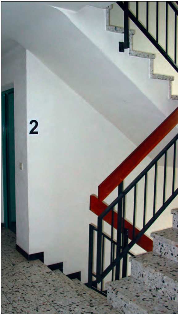
Große undkontrastreiche Treppenhausbeschriftung in Augenhöhe für sehbehinderte Menschen, die auch nicht-behinderten Menschen zugute kommt.
